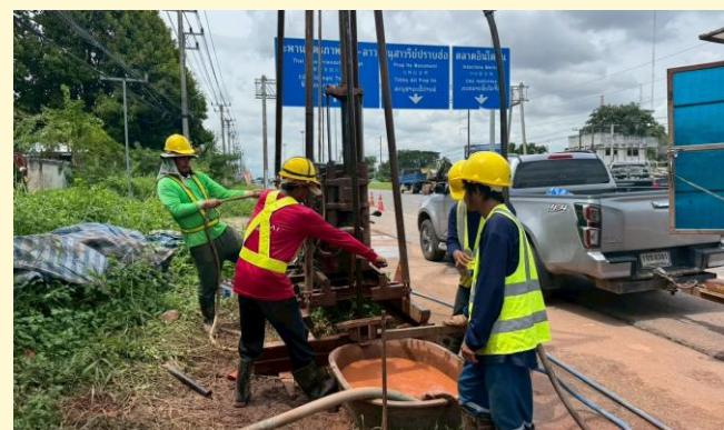
ตรวจสอบงานเจาะ Soil Boring Test จุดที่ 2 กม.0+004.700 (สาย ง3)
